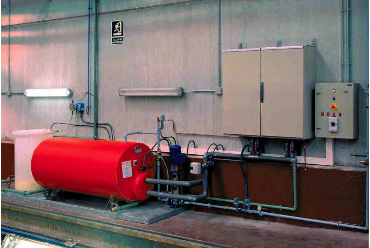
Lavado manual de bogies en las cocheras de Hortaleza
