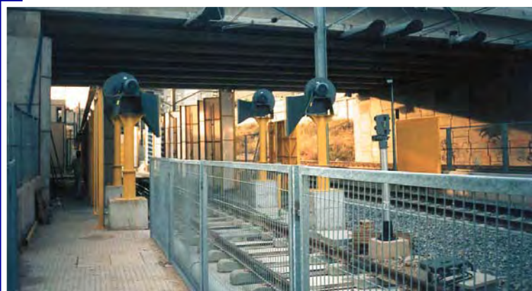
Vista general de la zona de secado
