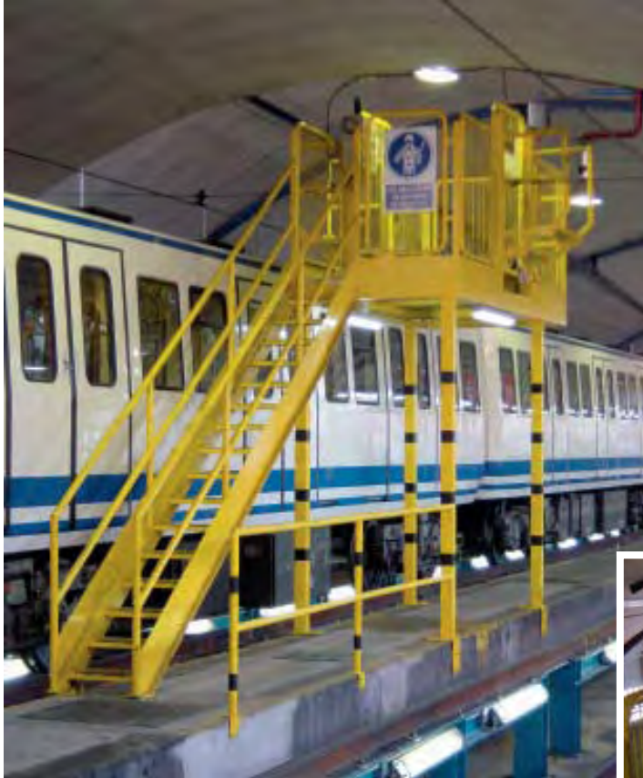
Detalle general de la estructura
