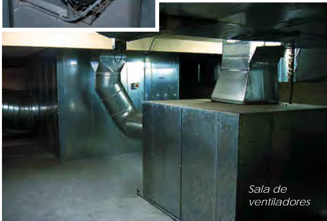
Silenciador en impulsión de ventilación de recirculación
