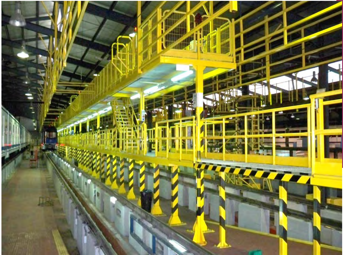
Vista general de la pasarela
