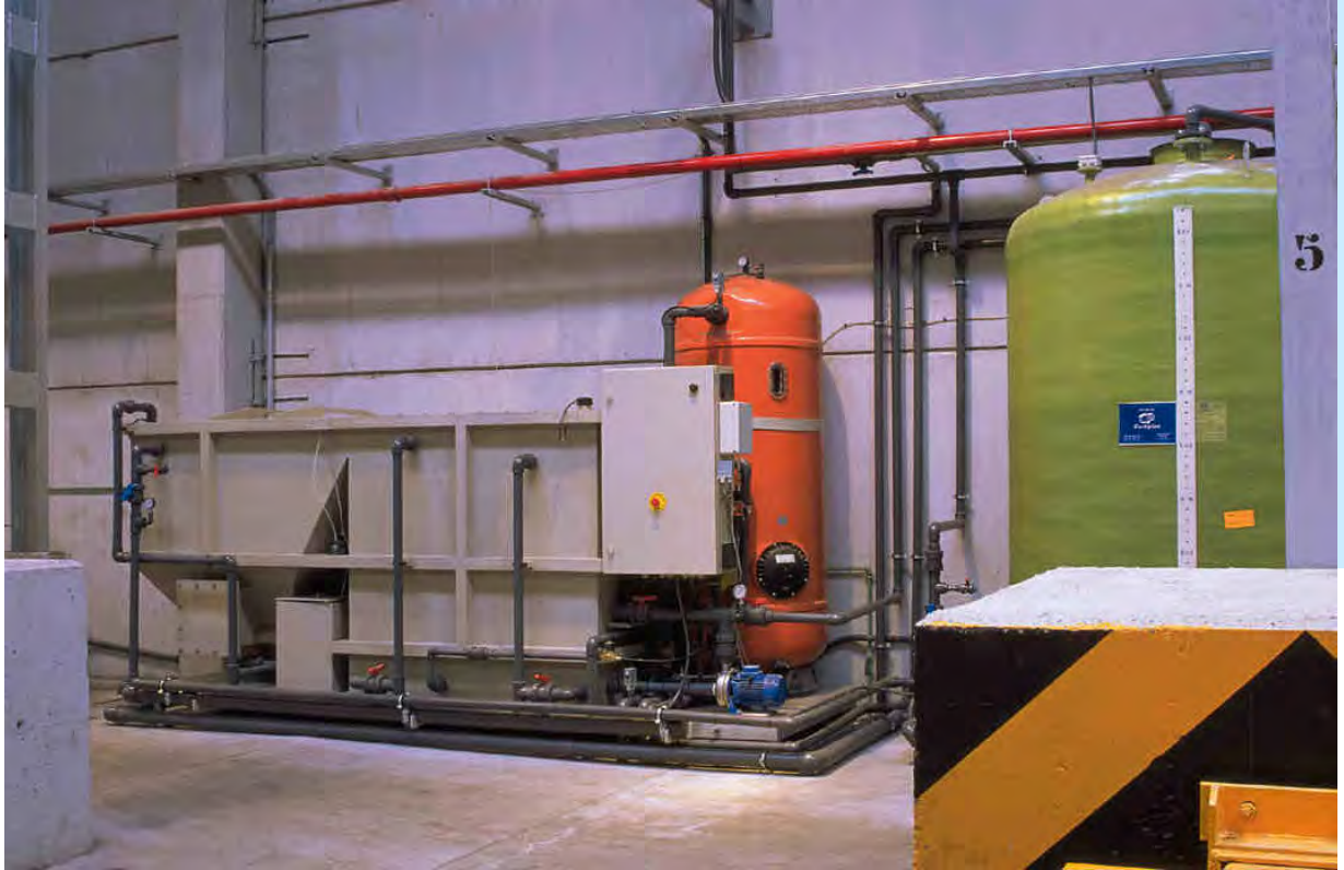
Recicladora y depósito de agua de red en túnel de lavado de Hortaleza
