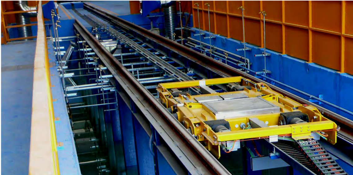
Lavado automático de bogies con carro de arrastre
