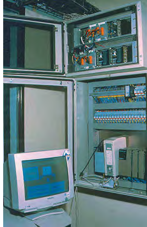
Armario de control y pantalla táctil
