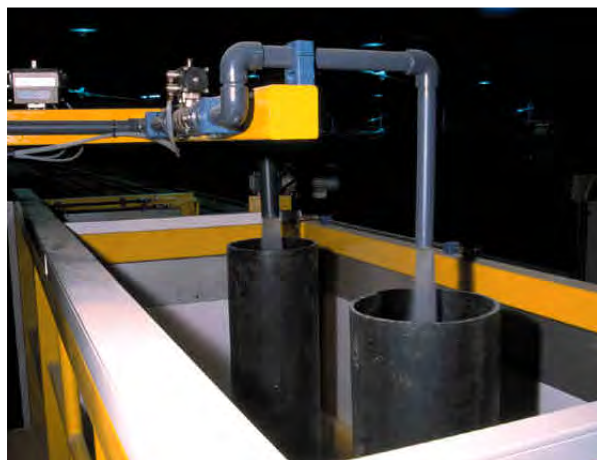
Llenado de depósitos de agua de red y agua reciclada
