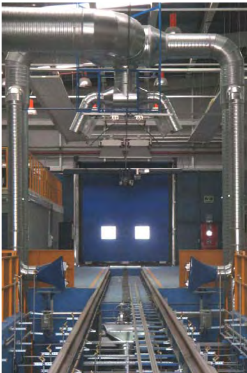
Distribución de conductos de aspiración
