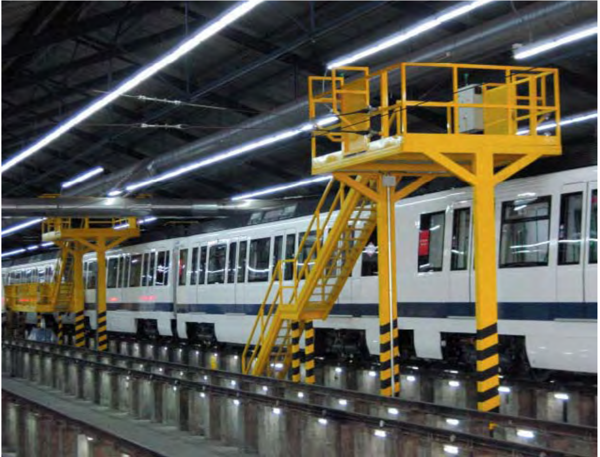
Vista general de la nave de pasarelas
