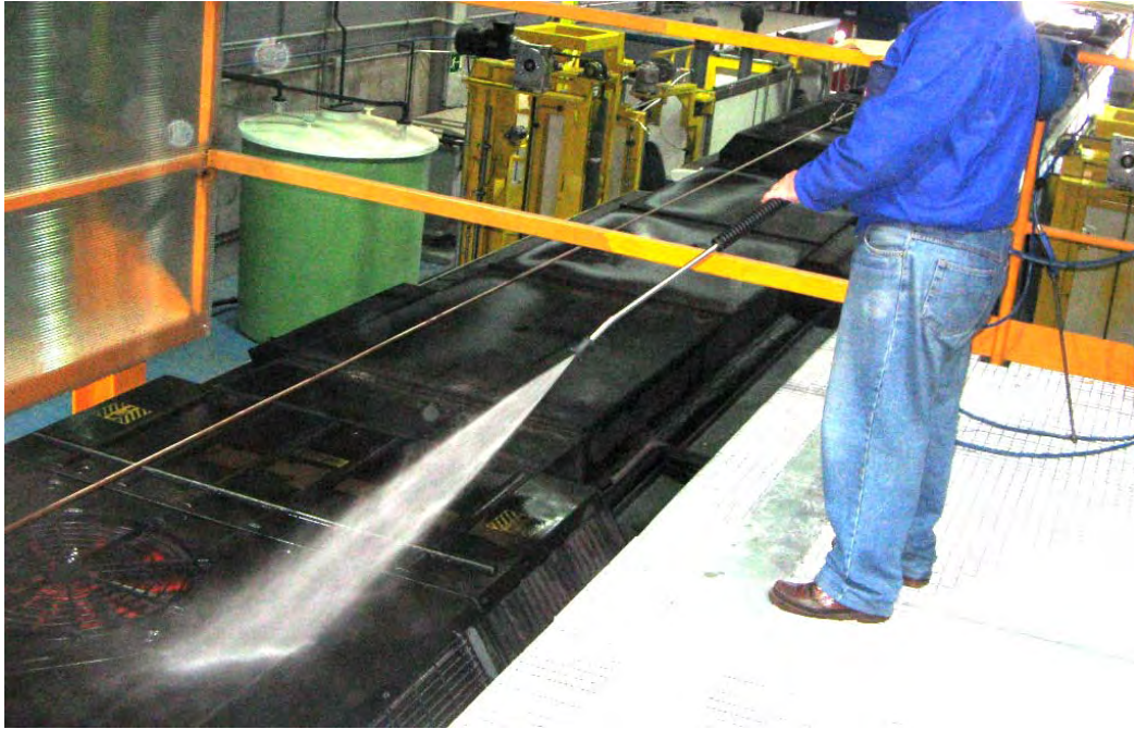
Vista general de lavado de aire acondicionado
