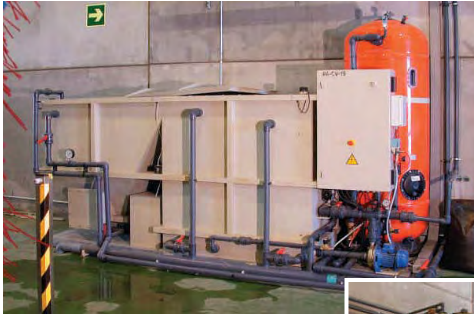
Recicladora de agua en el túnel de lavado al paso de Cuatro Vientos
