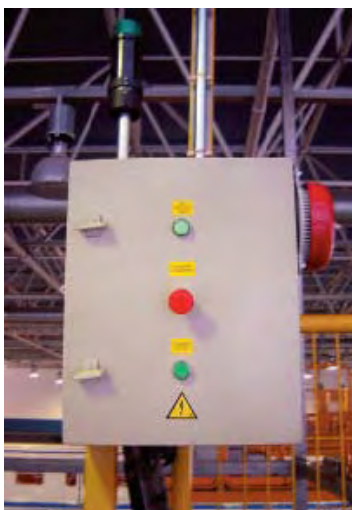
Frontal de armario y baliza luminosa
