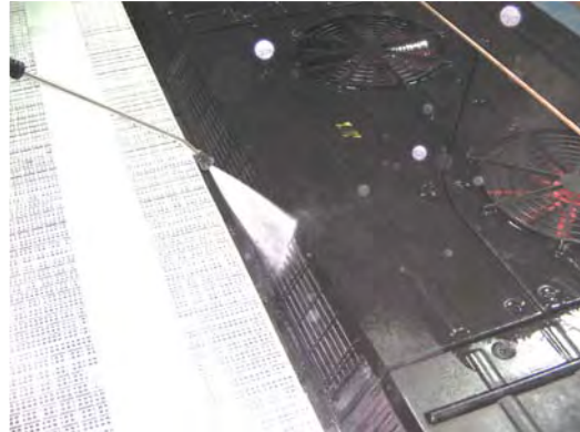
Lavado con agua caliente y detergente
