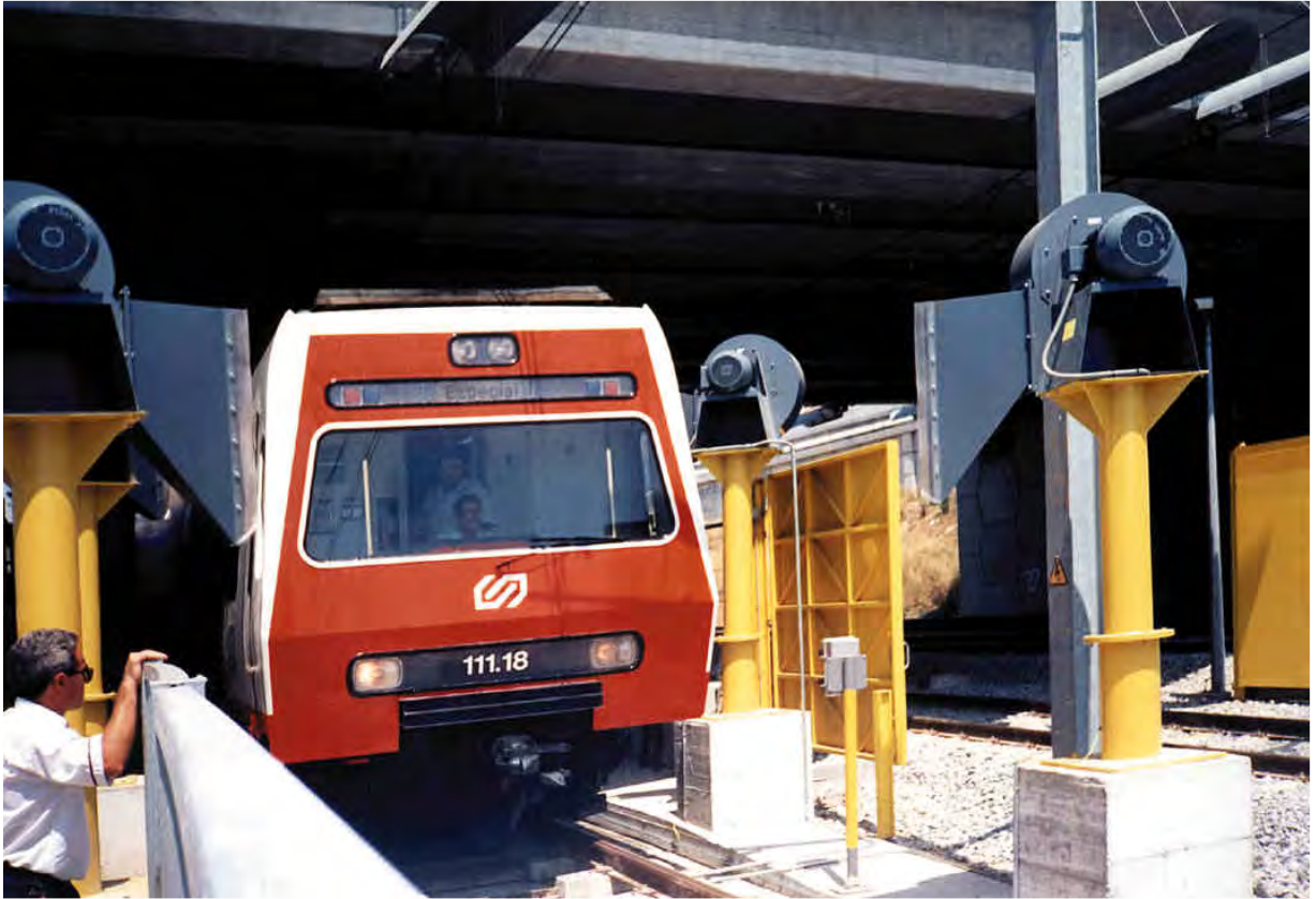
Túnel de lavado al paso de Rubí
