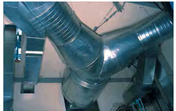
Silenciador en impulsión de ventilación de recirculación
