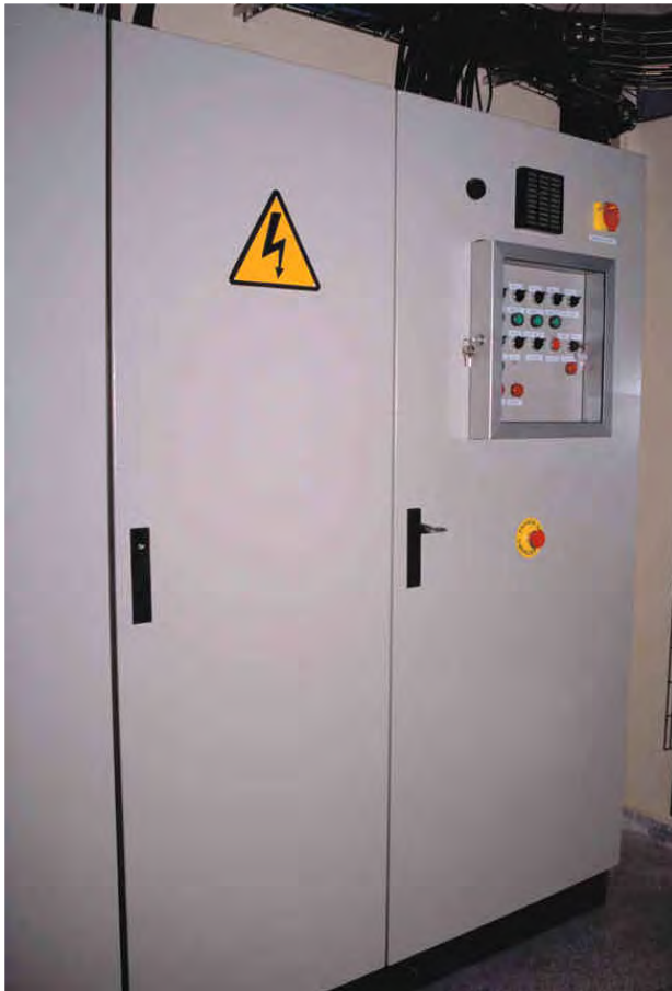
Armario de potencia
