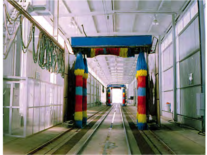
Vista general del túnel de lavado AVE
