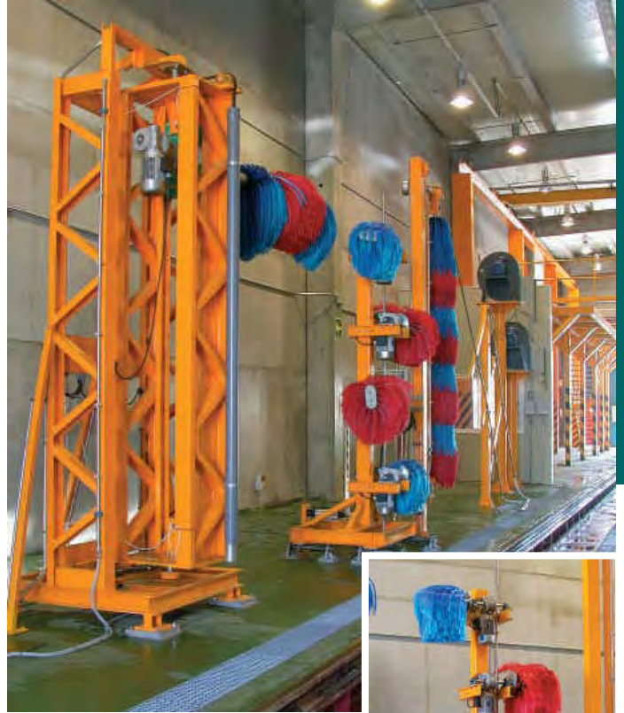
Vista parcial del túnel
