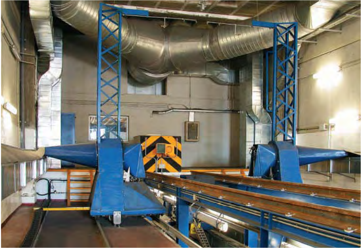
Vista general de la nave de soplado de Hortaleza
